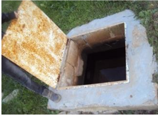
شكل 22. عين الوسيطة، البئر التجميعي
